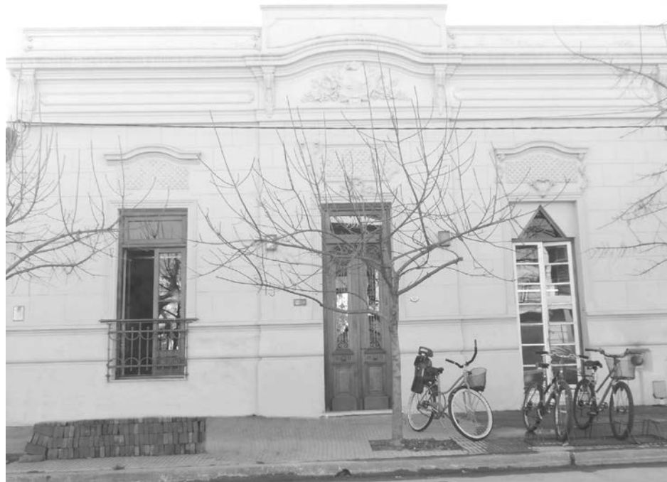
Vista del frente del nuevo edificio de la Escuela de Estética.
