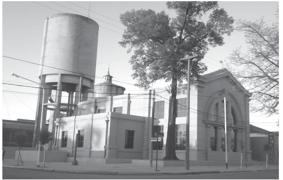
Vista panorámica del edificio remodelado que será inaugurado el jueves. Foto De Sogós.
