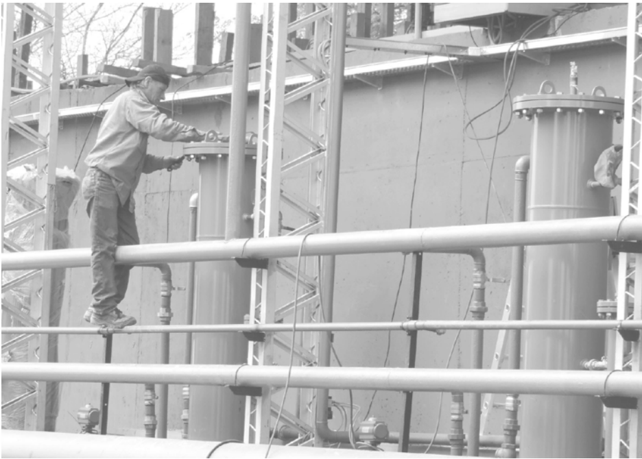
Operarios realizan controles y ajustes en la planta de abatimiento. Fotos De Sogos.
