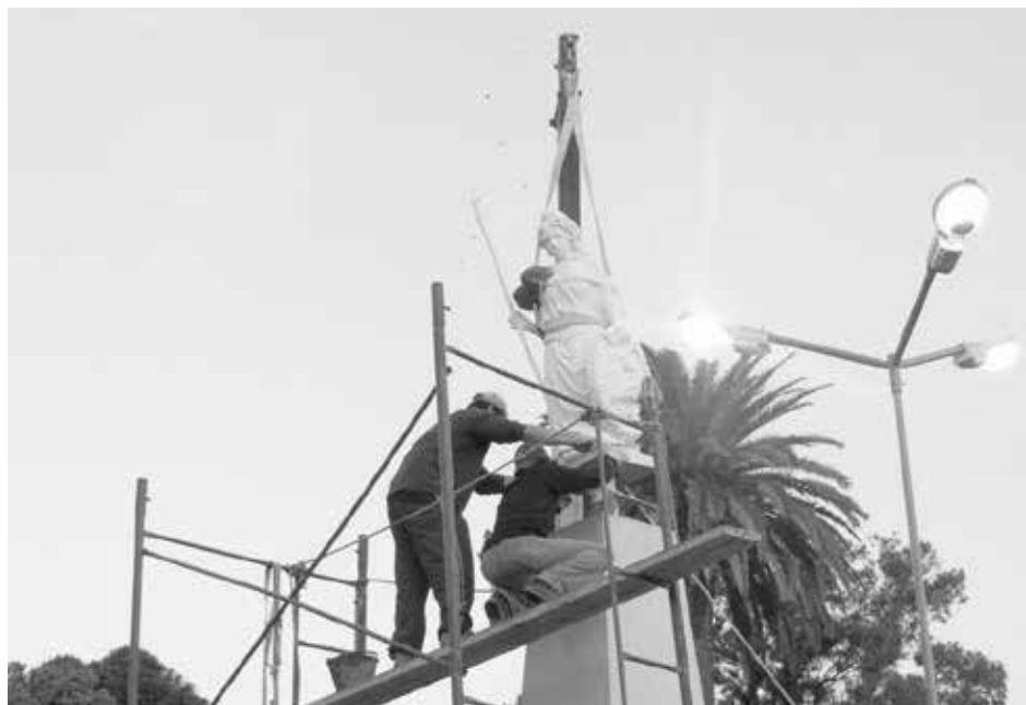
Operarios trabajan en la colocación de la escultura.
