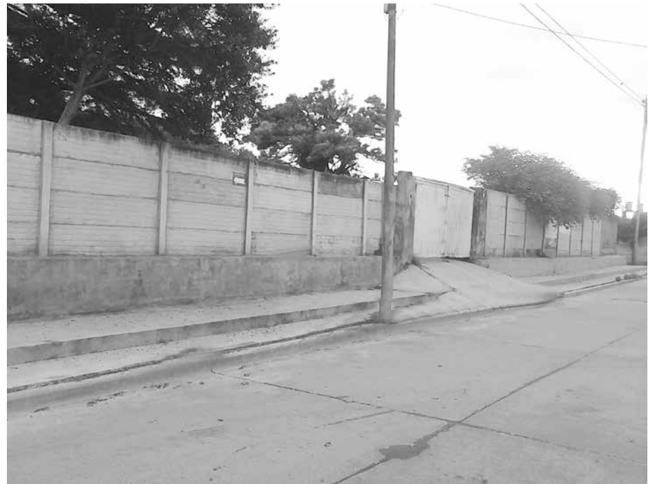
Vista del trabajo realizado por la CEyS en el Centro Educativo. Foto De Sogos.
