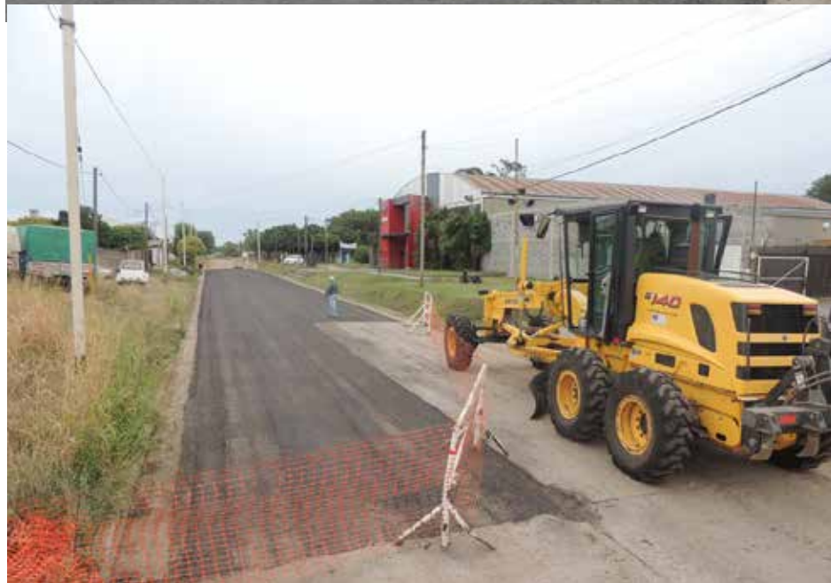
Vista de los trabajos de asfalto en frío en calle Pueyrredón.
